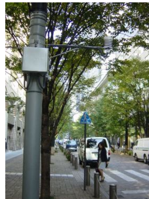
A地区中心部に設置された LiveE!センサー
